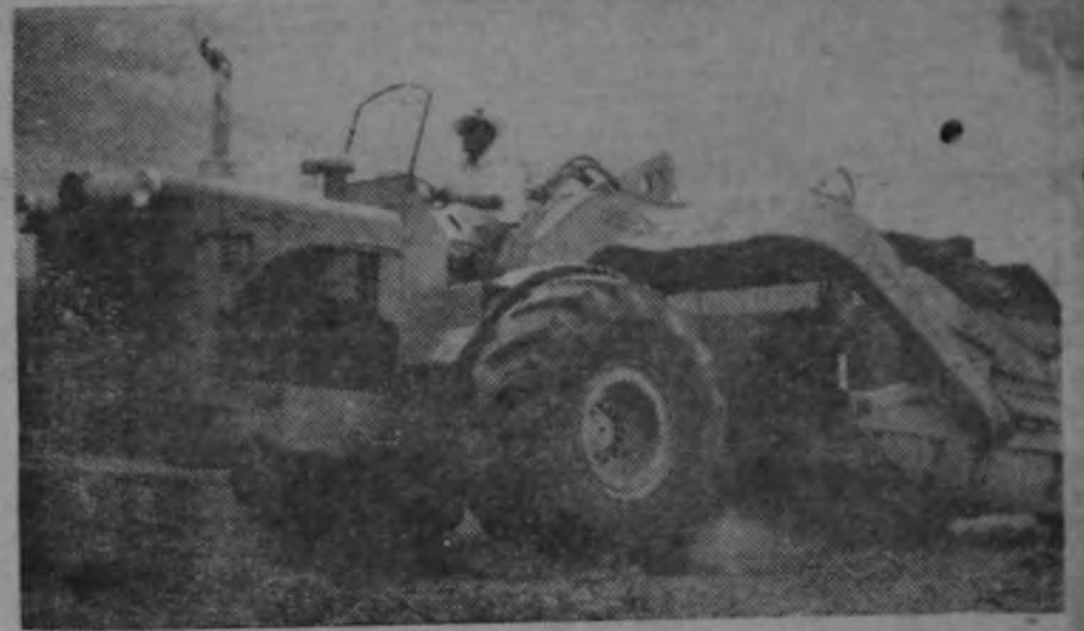
Una de las modernas maquinarias que están siendo utilizadas en los trabajos de construcción del nuevo aeropuerto internacional de El Coco.—(FOTO GONZALEZ CAMPO).
